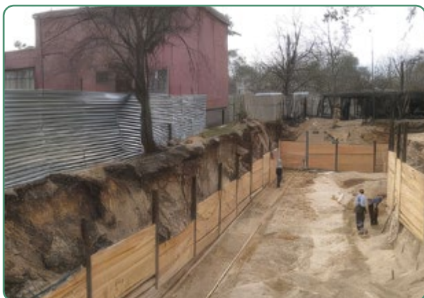
Zdj. 3 Przykład ścianki berlińskiej (Źródło: http://www.geotekst.pl/aktualnosci/technologie/do-czego-sluzyc-ścianka-berlińska ).
