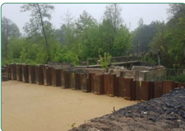
Zdj. 4 Przykład ścianki szczelnej traconej (źródło: https://pgts.eu/scianki-szczelne/scianki-szczelne-tracone/#1 )
