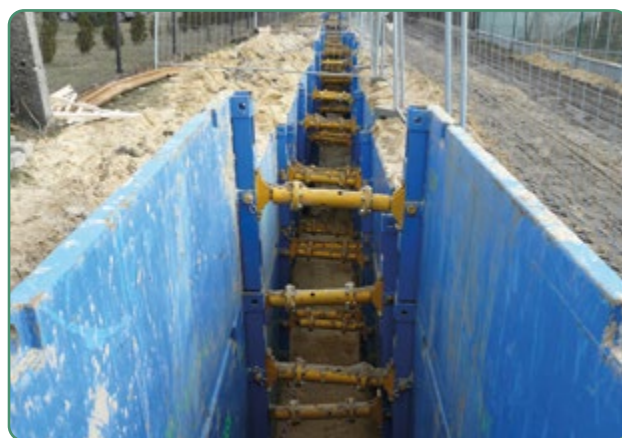
Zdj. 5 Przykład ściany rozporowej (źródło: https://zremb-poland.com.pl/wp-content/uploads/2023/01/583-1024x768.jpg ).
